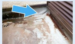
下地と防水層の間に入り込んだ水分や湿気が蒸発する事で発生した膨れ
