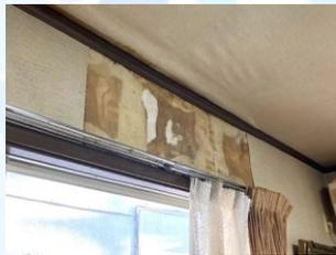
3 防水材の亀裂・剥離などからも大雨により浸水することがあります。
